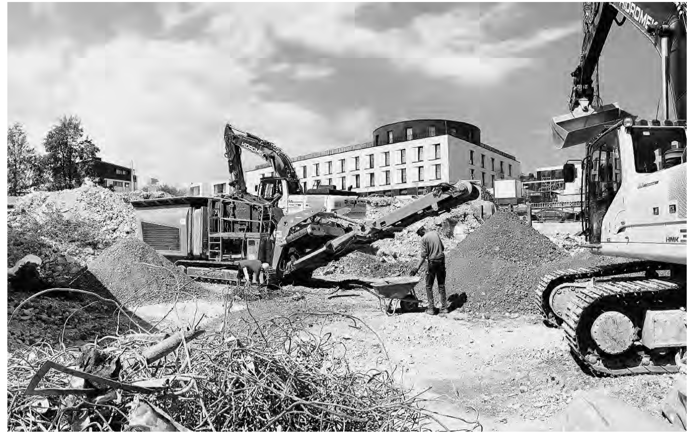
180 bis 200 t/h stark armierten Bauschutt bricht der Rockster R1000S in Tutzing auf 0-50 mm.
